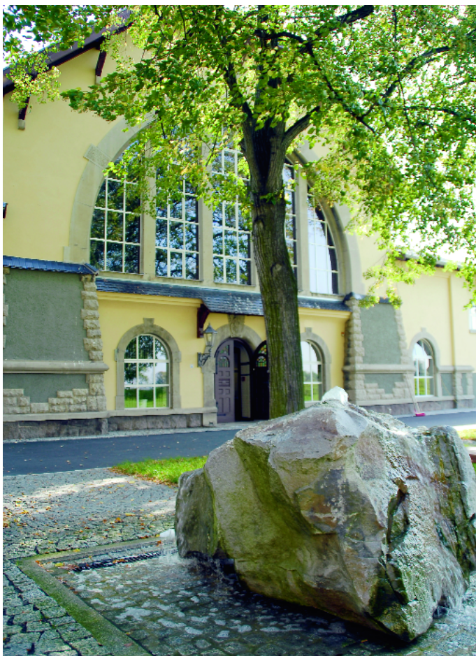
> Denkmalgeschütztes Gebäude, hochmodernes Innenleben: das 1912 in Betrieb genommene Wasserwerk Canitz.
