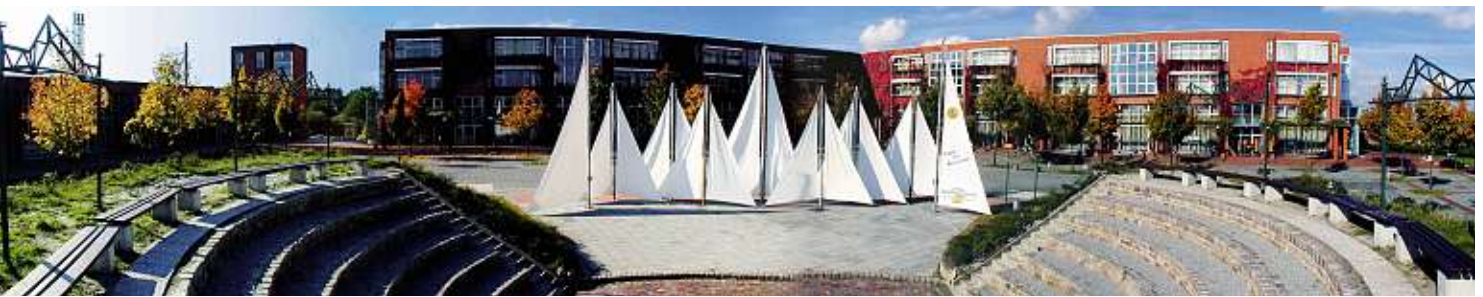
BBS II Emden, Amphitheater mit Schulgebäude.
